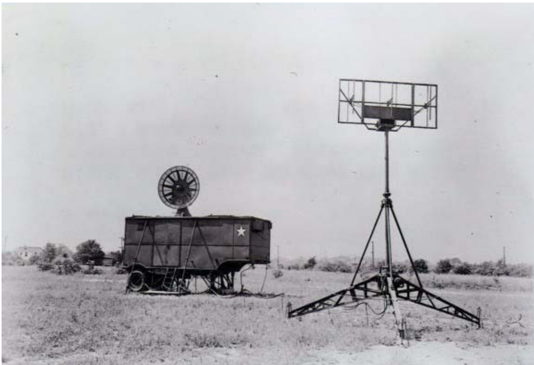
Fig. 11. Un radar americano de dirección de tiro de cañones antiaéreos SCR-584 junto con una antena de IFF (a la derecha).
