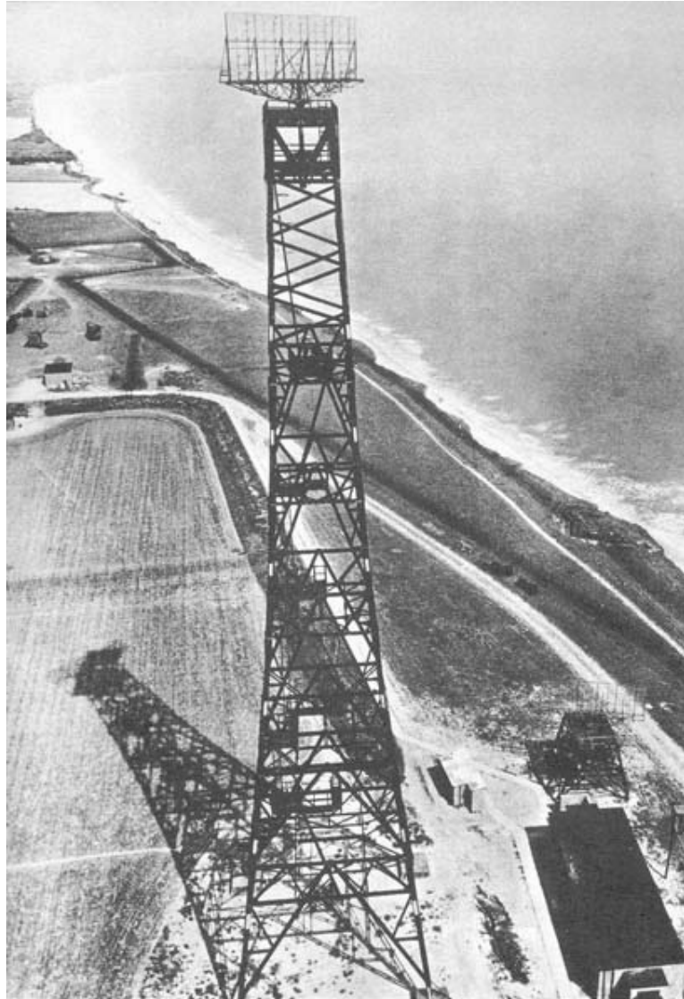
Fig. 4. Antenas del sistema Chain Home Low , versión de vigilancia a baja cota.
